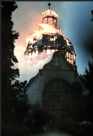
La sinagoga de Frankfurt en flames, novembre de 1938.
